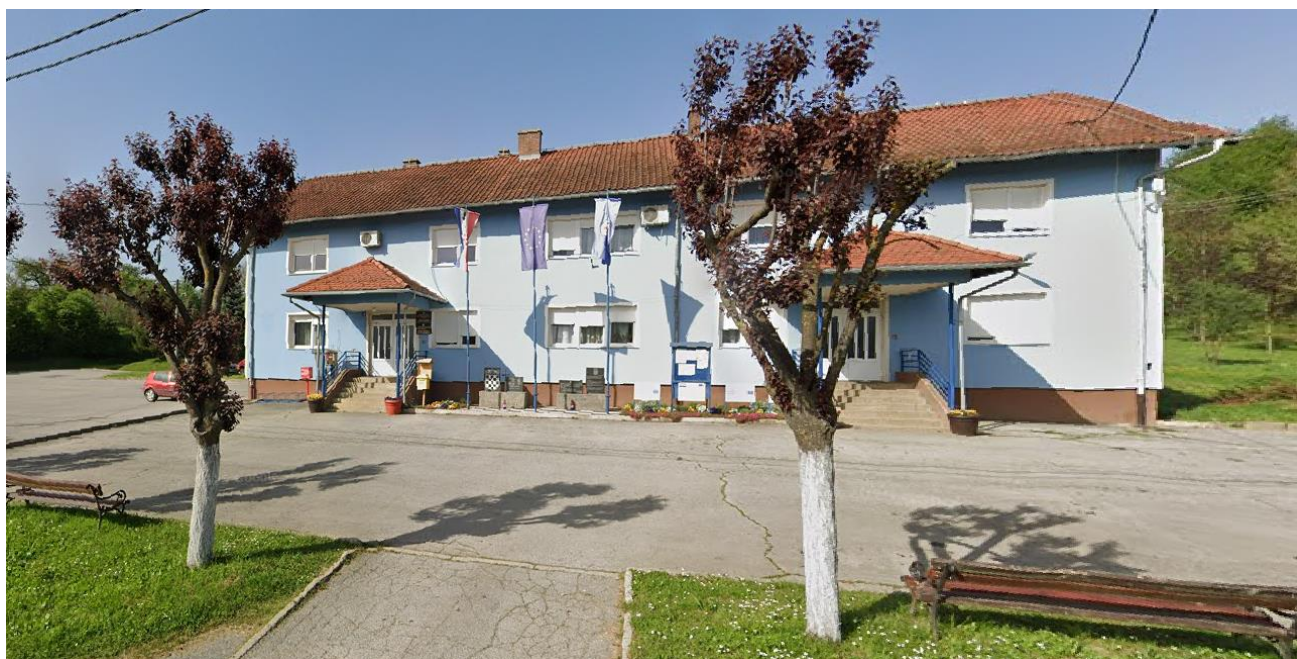
Fotografija 17. Zgrada Općine i Društveni dom Šandrovac Izvor: GoogleMaps
